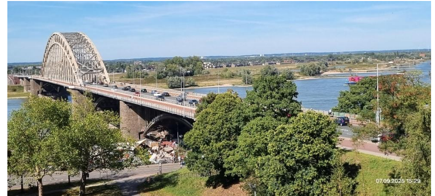
Treppauf u. Treppab „scheute“ uns der Gästeführer, doch nur so konnten schöne Aufnahmen gemacht werden.
