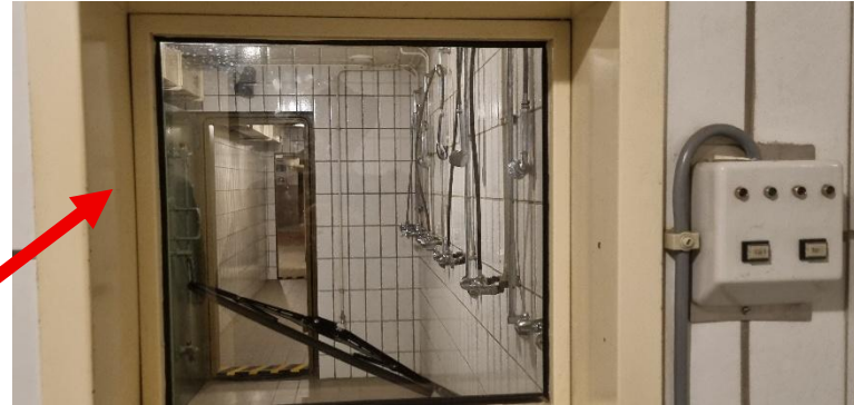
Das Fenster des Kontrollraumes zwecks Überwachung (Piepschow) während der Dekontaminierung der Personen.
