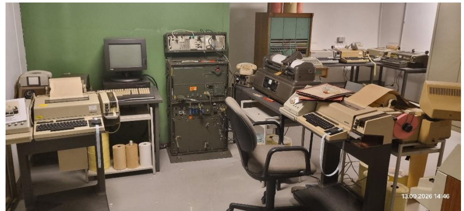
Ein Blick in die Fernmelde- u. Nachrichtenzentrale.
