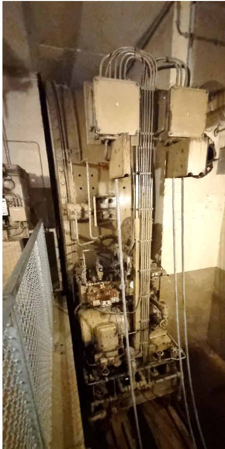
Bild l.: Die Schließmechanik der Bunkertüren im ehem. Regierungsbunker. Bild r.: Hier stehen wir im Dekontaminierungsraum.
